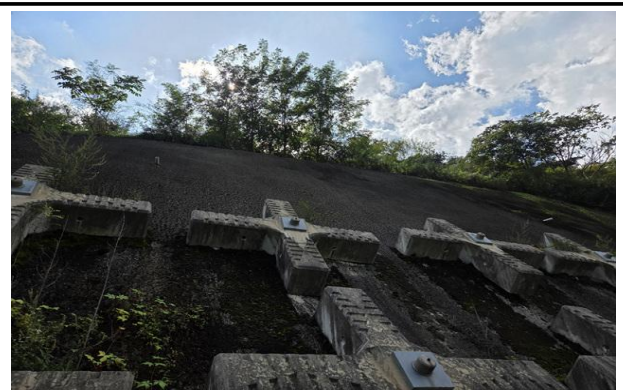
숯크리트 전경(상단) 및 격자앵커 전경
